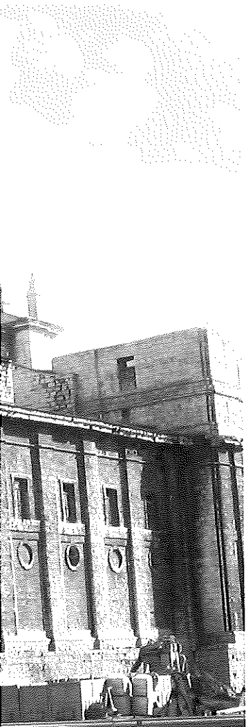
Las obras han comenzado y avanzan a buen ritmo
